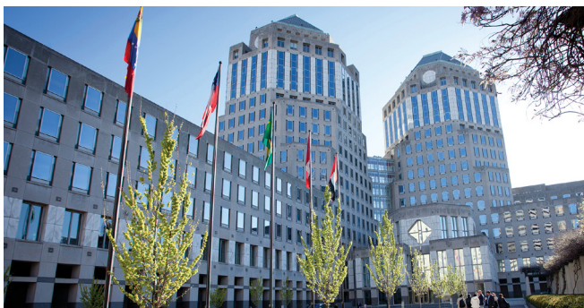
Bei Procter & Gamble, hier die Firmenzentrale in Cincinnati, können sich die Anleger auf die Dividende verlassen.
